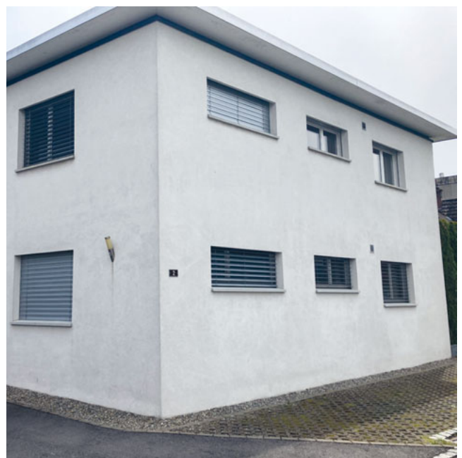
Fassade ca. ein Jahr später
