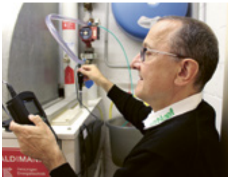
Umfassende Zustandsanalyse vor Ort.
