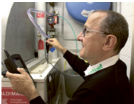
Umfassende Zustandsanalyse vor Ort.
